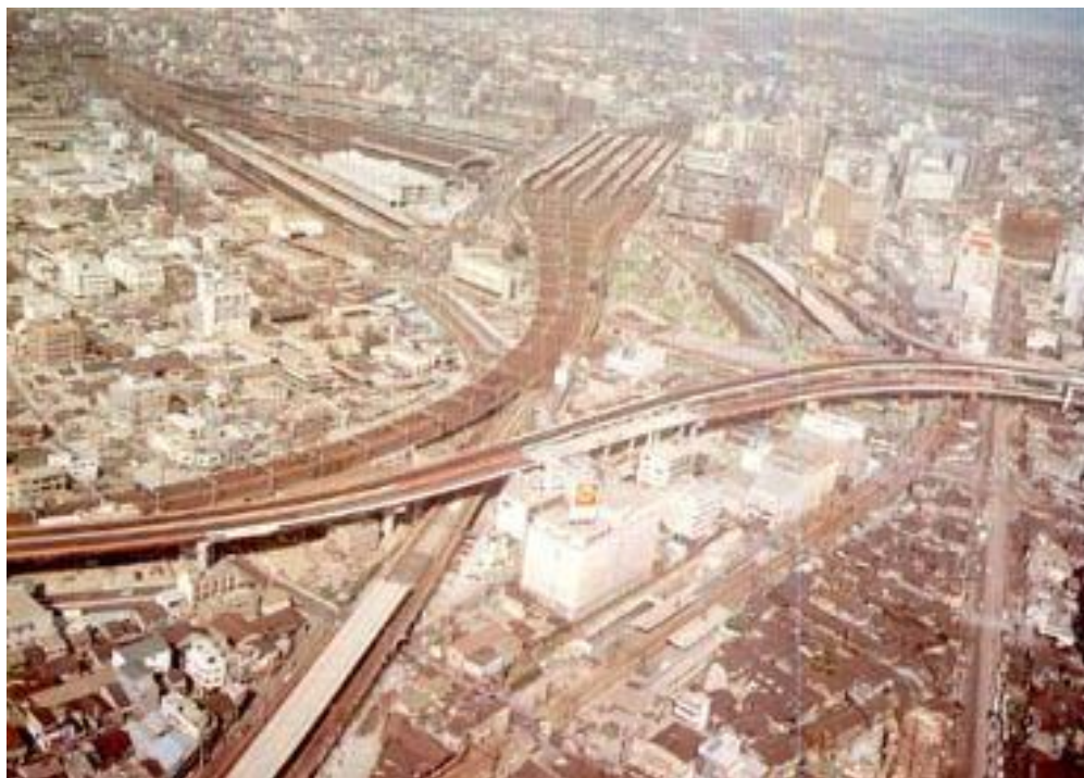
写真一 1 福島第一高架橋 写真提供 東京鐵骨橋梁
