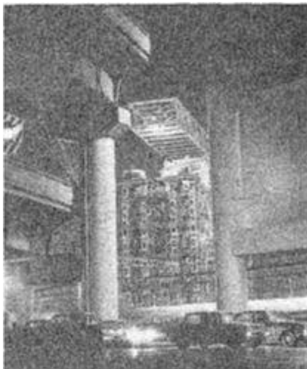
写真一 2 福島第一高架橋の夜間工事 写真提供 阪神高速道路
